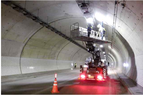
터널 내부 고소점검차 조사
