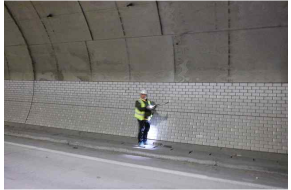
터널 내부 도보조사
